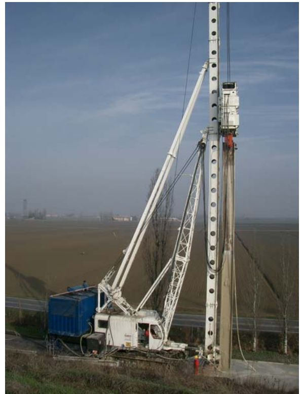
Attrezzatura di perforazione diaframma con metodologia a vibroinfissione
