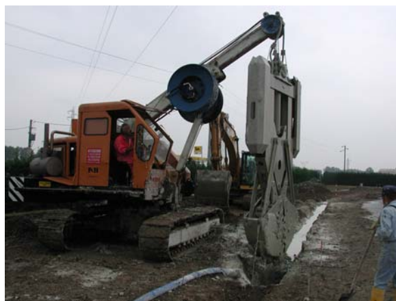
Attrezzatura di perforazione Microdiaframma sp 300 mm
