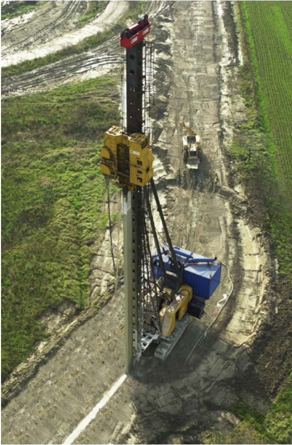
Attrezzatura di perforazione diaframma con metodologia a vibroinfissione
