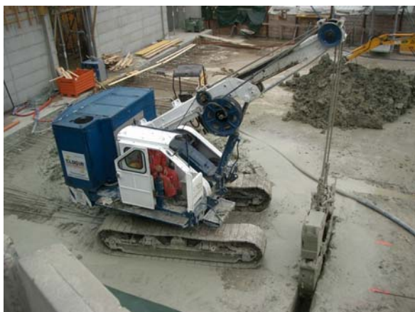
Attrezzatura di perforazione Microdiaframma sp 300 mm
