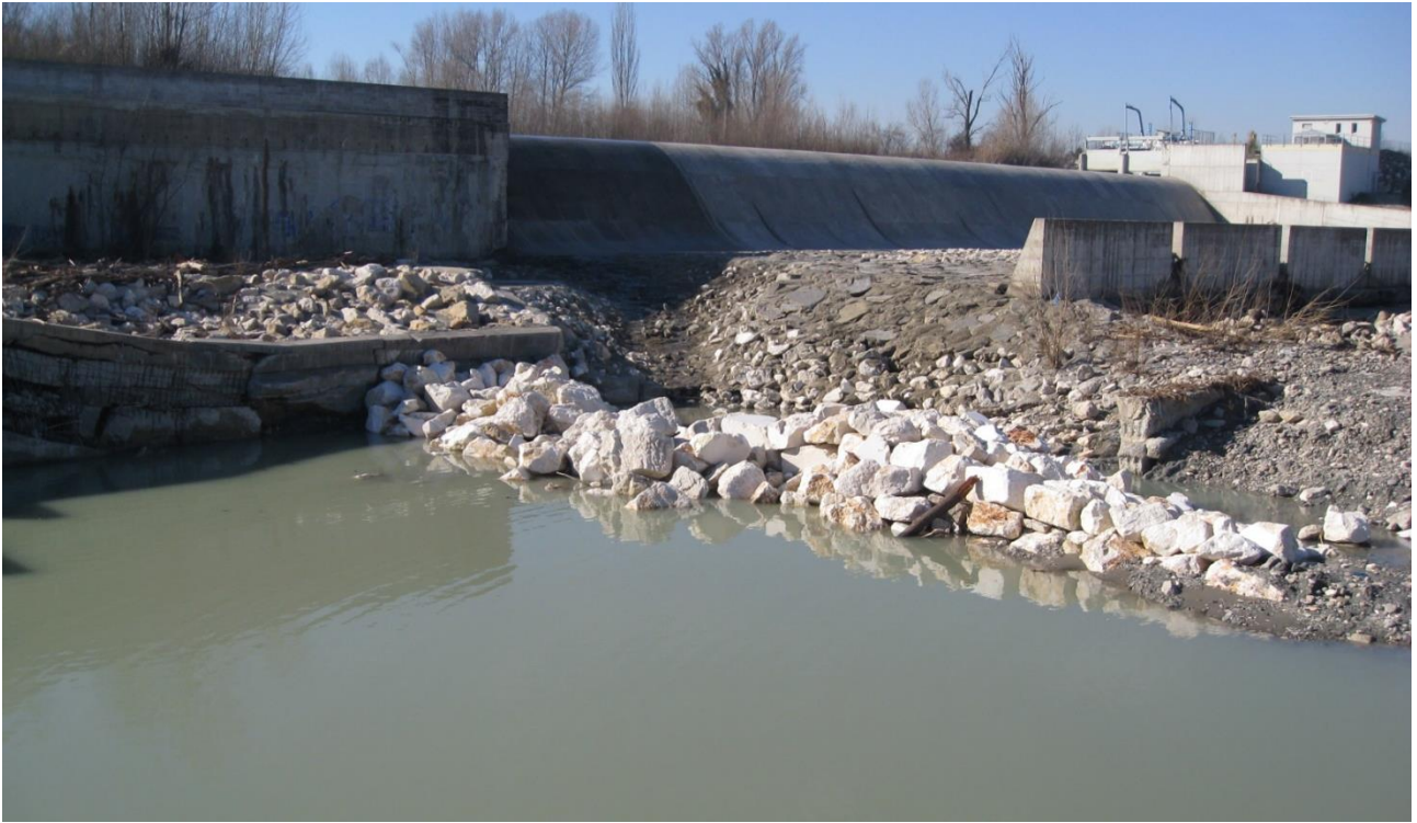
Figura 2 Soggettiva della cavità presente sul fondo alveo a valle del sistema di dissipazione esistente.
